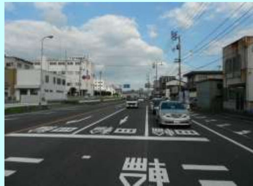
街路整備区間
