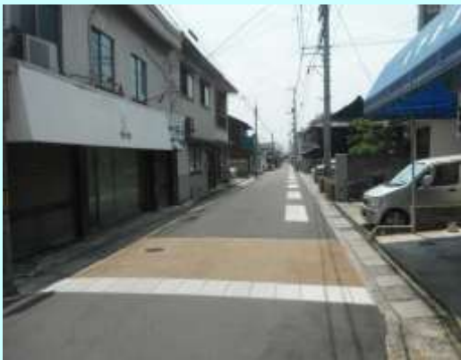
【高質空間形成施設】 石張り舗装
