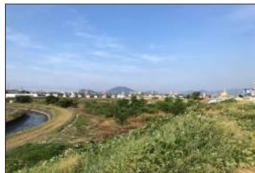
【第2多目的広場（整備中）】
