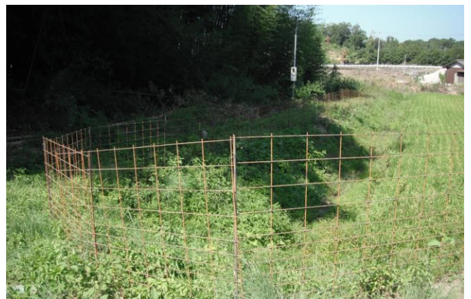
侵入防止柵の設置
