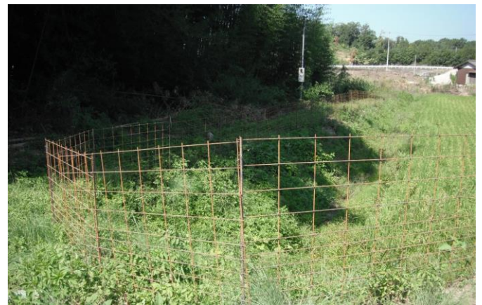
侵入防止柵の設置
