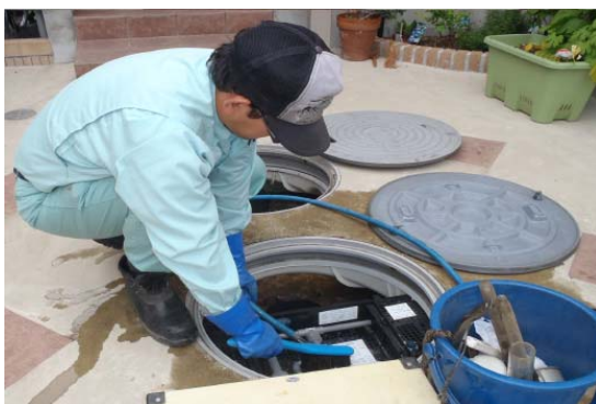
浄化槽の検査状況
