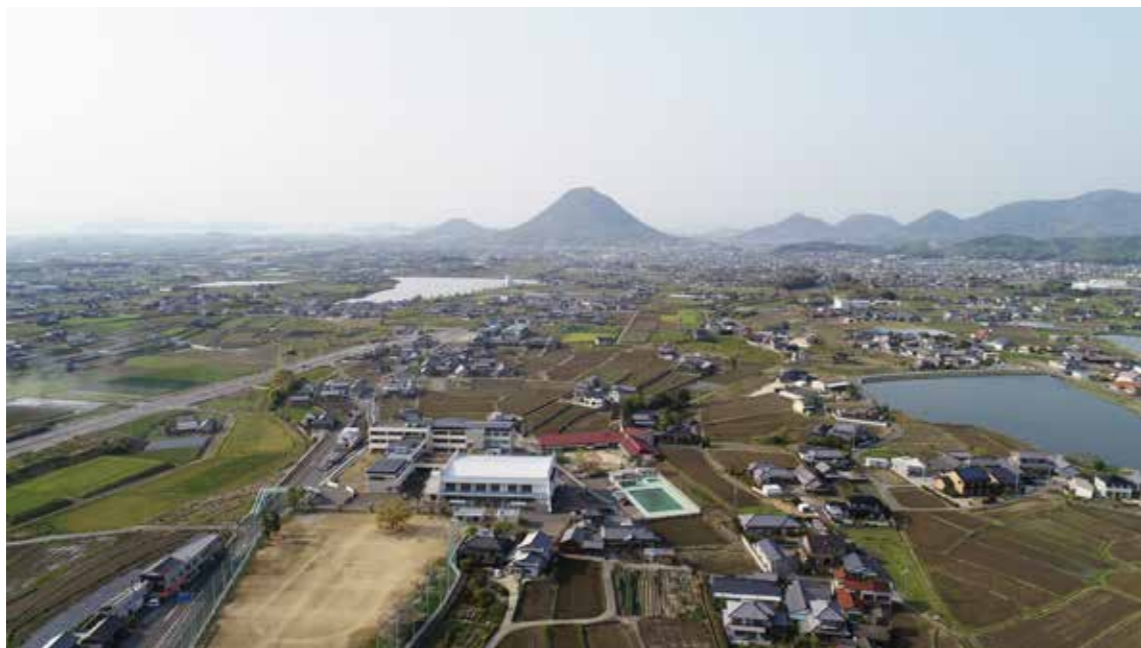
岡田コミュニティセンター上空約100mから見た丸亀平野
