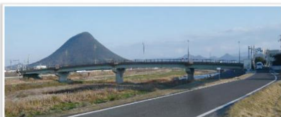
■丸亀橋(城東小学校東)
