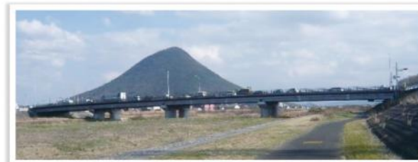
■丸亀大橋(国道 11 号)
