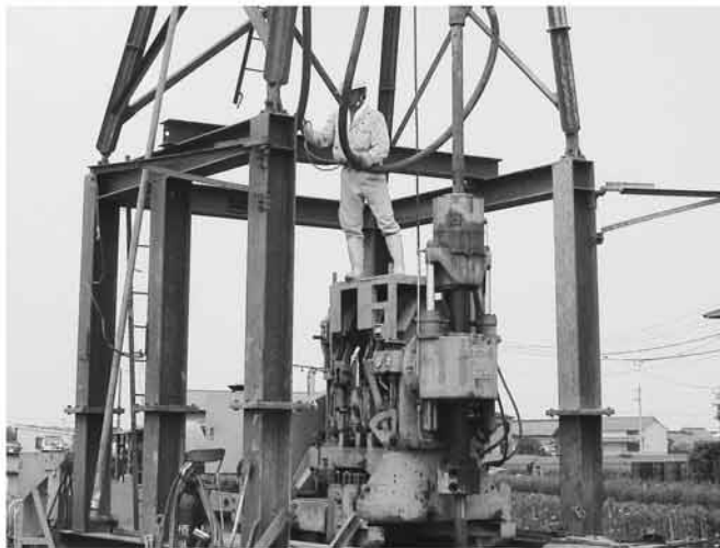
平成17年に温水対応の深井戸を掘削（飯山町）
