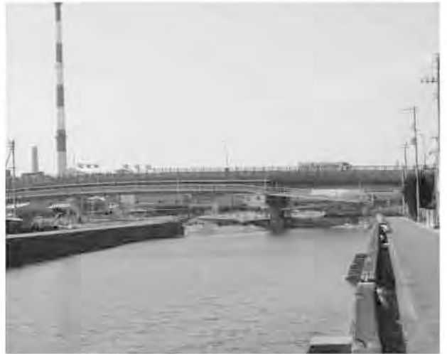
平成24年度に撤去予定の富士見大橋
