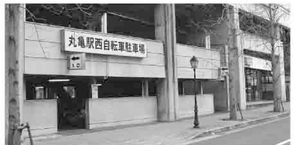
指定管理者が管理運営する自転車駐車場
