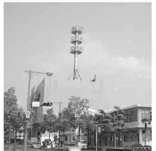
建築中の新消防庁舎
