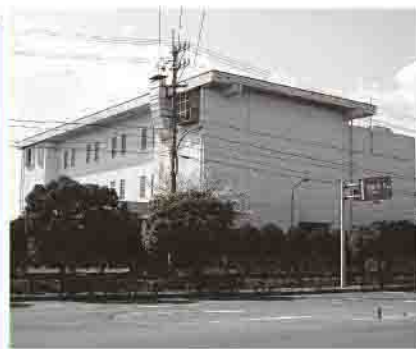
城西ポンプ場
