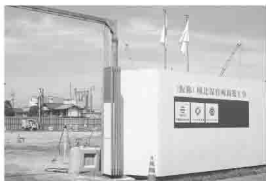
新築工事中の（仮称）城北保育所
