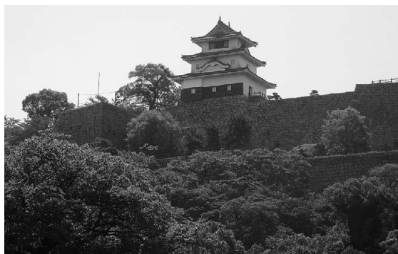
石垣修復が進む丸亀城
