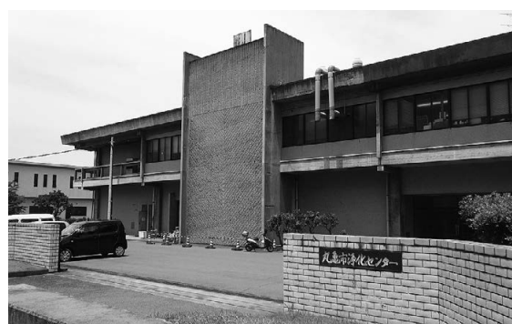
建て替え予定の市浄化センター
