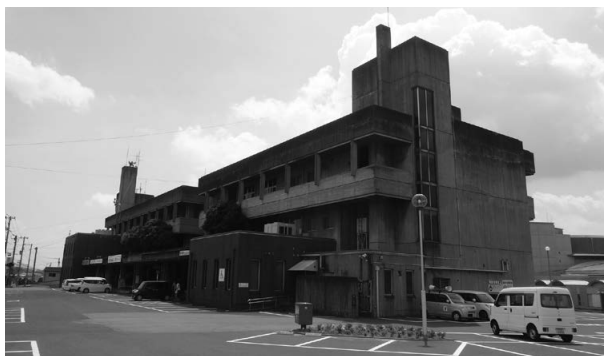
耐震改修工事予定の綾歌市民総合センター
