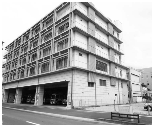
ホース乾燥場設置予定の消防署西面
