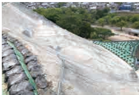
斜面安定・表面排水処理
