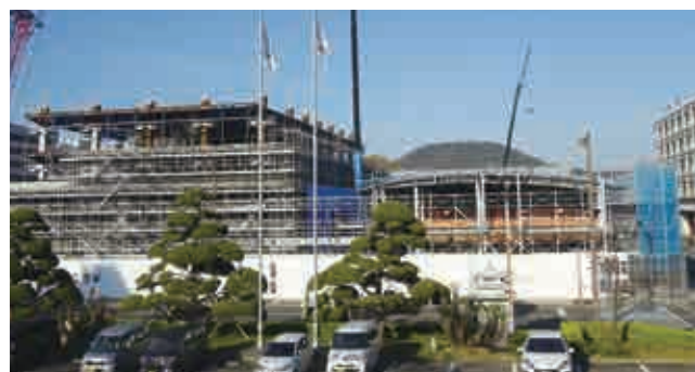
建設中の市民交流活動センター
