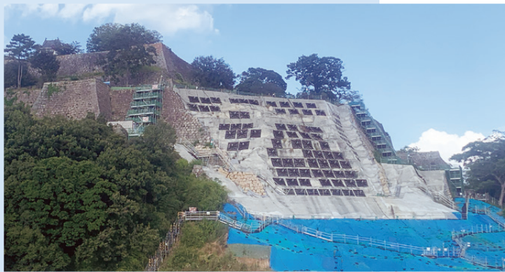
石垣復旧の様子
