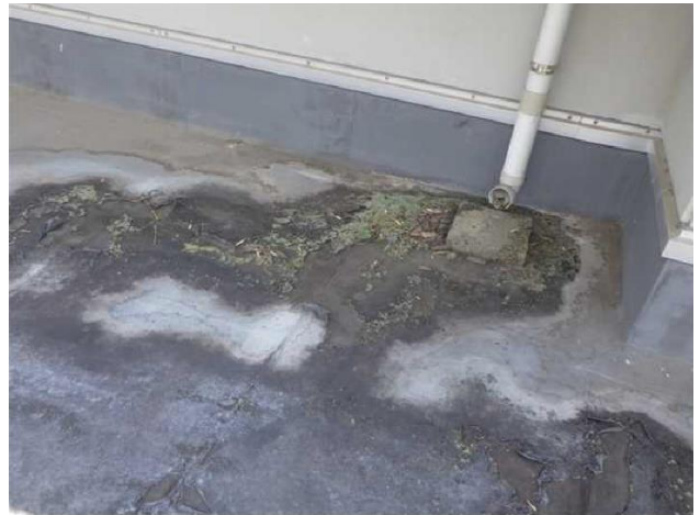
⑩待合ホール上部（金属葺屋根）の表面劣化
