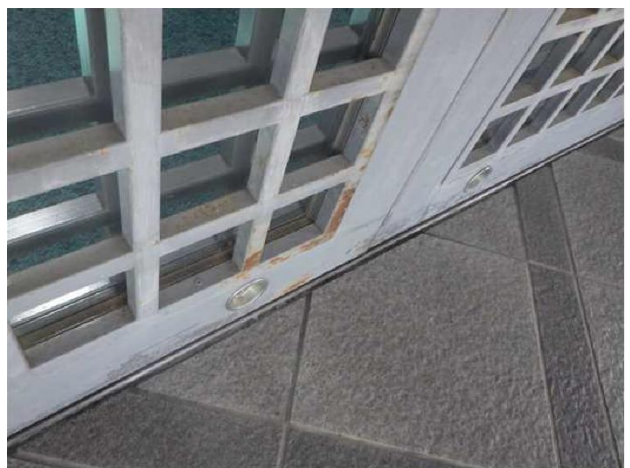
⑥サッシのスチール部の発錆・退色
