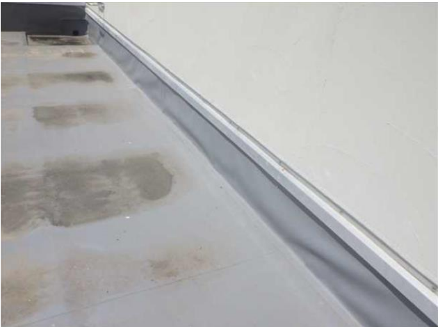
⑪防水層（エントランスホール）の表面劣化、立上り浮き
