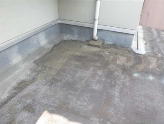
③玄関（金属葺屋根）の表面劣化
