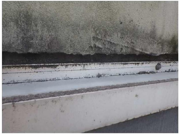
④外壁のひび割れ、塗装割れ
