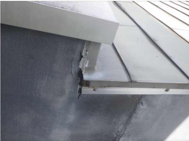
⑪防水層（エントランスホール）の表面劣化、立上り浮き
