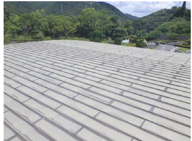
⑪防水層（エントランスホール）の表面劣化、立上り浮き
