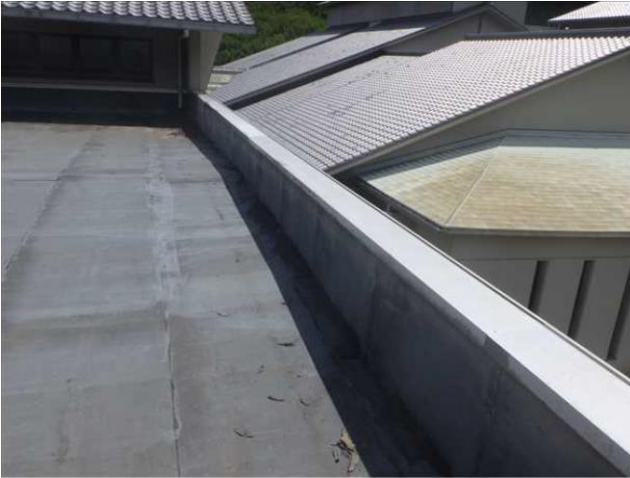
⑨防水層端部のシーリング劣化
