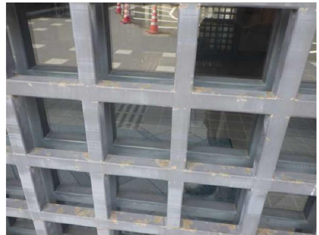
⑪防水層（エントランスホール）の表面劣化、立上り浮き
