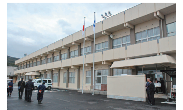
旧丸亀中学校を改修。丸亀市民センター、コミュニティセンター、消防団第3分団屯所が移転し、新たな地域の拠点へ。
