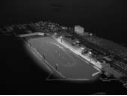
高さ40mの照明灯を8基設置。平成21年春からは、オールナイターレースでの営業を予定。
