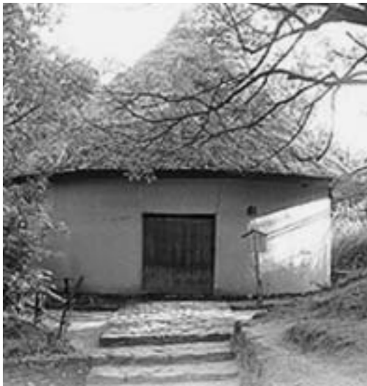
四国村砂糖しめ小屋(高松市)
