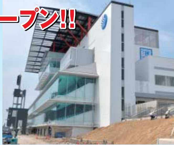
完成間近の新スタンド
