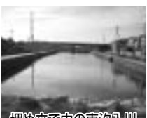
埋め立て中の東汐入川
