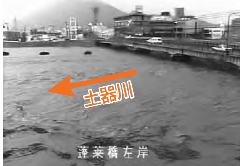
土器川出水状況(平成16年10月) 丸亀市では、土器川の支川が氾濫し家屋浸水(床上75戸、床下142戸)が発生
