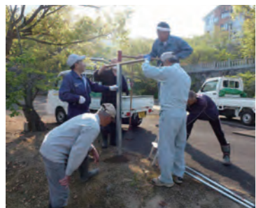
みんなで協力して看板を設置
