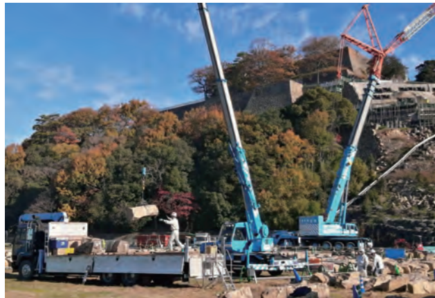
解体した石を運び出します
