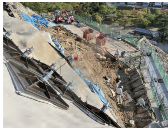
三の丸石垣復旧現場(11月6日現在)
