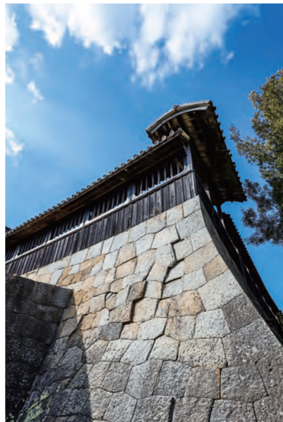
4.5メートルの高さを誇る尾上邸の石垣
