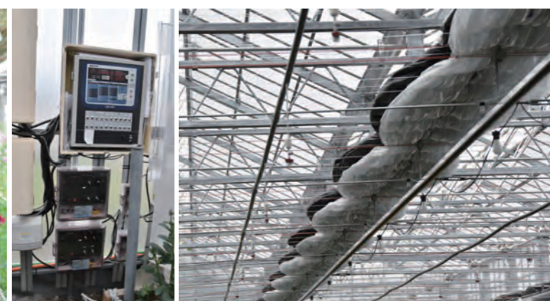
ハウスの設備。温度、湿度、光量などを機械で自動調整
