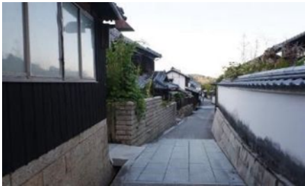
石材を用いた基礎や塀（本島）
