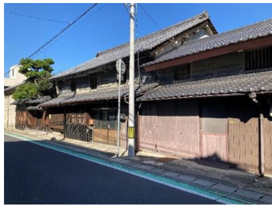
古いまち並みが一部残っている
